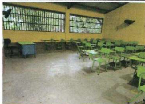
Foto 4: Aulas 1,2 y 3 primer nivel que se colocaran piso ceramica.
