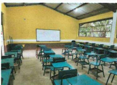
Foto 3: Aulas numero 1,2,3 y 4 del segundo nivel que se colocaran piso ceramica.
